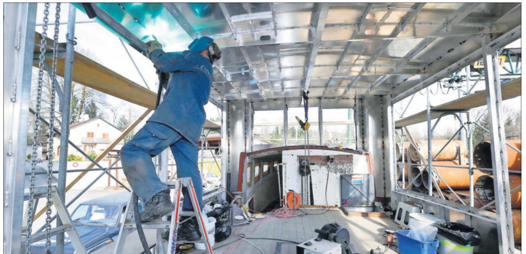
Noch wird auf dem Baarer Gulm an der Renovation des MS «Schwan» gearbeitet, das aber schon bald wieder auf dem See im Einsatz sein soll.
